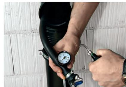
Aufpumpen der Prüfblase mit Blasebalg; Prüfblase in der Reinigungsöffnung einer Abwasserleitung
