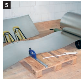
Mit einfachen Hilfsmitteln (Europalette) lässt sich die Arbeit auf der Baustelle erleichtern Une simple palette „EUROPE“ vous facilite son utilisation sur chantier With simple aids (euro pallet) the work on the building site can be facilitated
