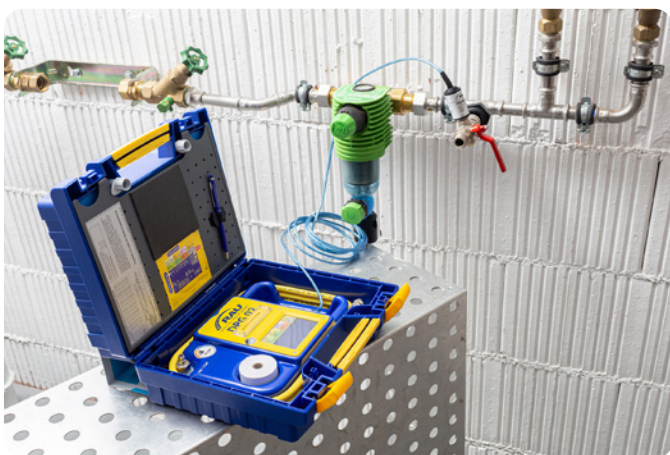
Dichtheitsprüfung einer Wasserleitung mit WPS Kabel
